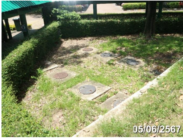
รูปที่ 3-20 ถังกรองไร้อากาศ สำหรับบำบัดน้ำเสีย จากกิจกรรมของพนักงาน
